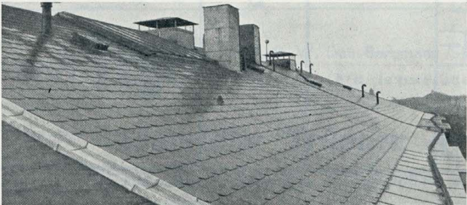
Eternittak å bostadsfastighet å Ladugårdsgårde, Stockholm.
